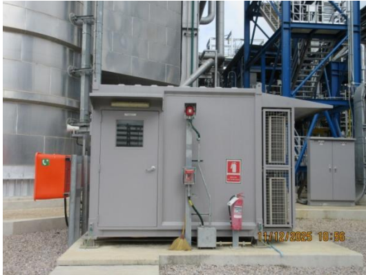
รูปที่ 3-4 เครื่องมือตรวจสอบคุณภาพอากาศแบบต่อเนื่อง (CEMS)
