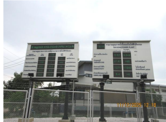
รูปที่ 3-5 จอแสดงผลการตรวจวัด CEMS บริเวณด้านหน้าโรงไฟฟ้า
