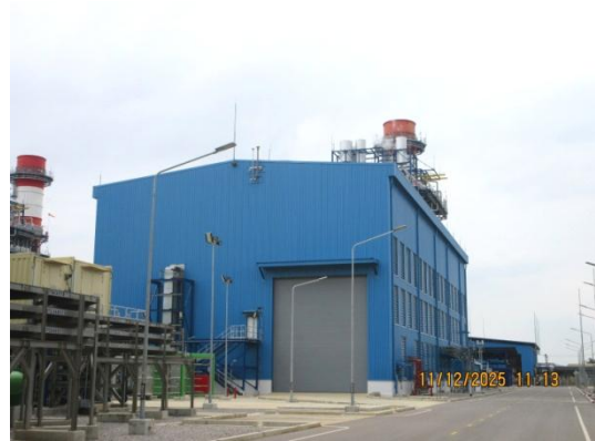
รูปที่ 3-11 Enclosure ครอบเครื่องจักรที่มีเสียงดัง
