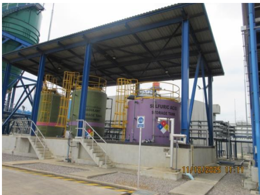
รูปที่ 3-40 ขอบคัน (Dike) บริเวณพื้นที่กักเก็บสารเคมี
