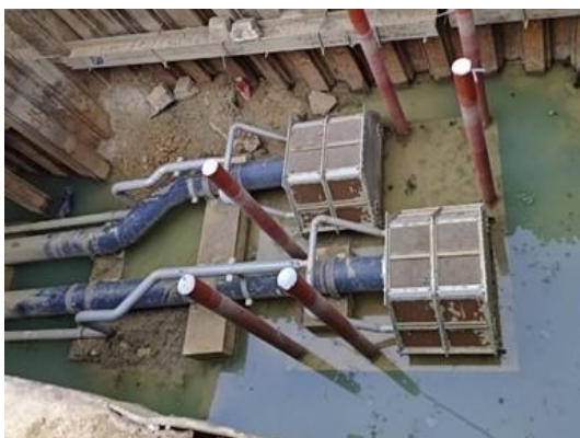
รูปที่ 3-19 ตะแกรงดักขยะที่ปลายท่อสูบน้ำบริเวณแม่น้ำแม่กลอง
