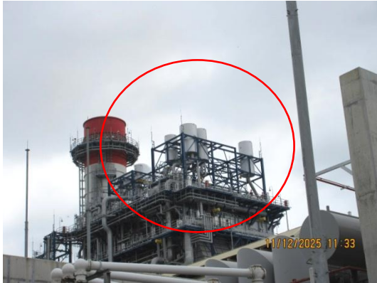
รูปที่ 3-10 Silencer บริเวณ HRSG
