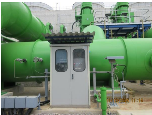
รูปที่ 3-23 ระบบ Online Monitoring บริเวณหอหล่อเย็น (Cooling Tower Basin)
