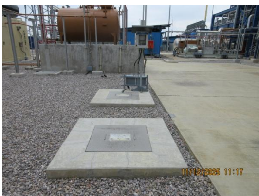
รูปที่ 3-25 บ่อแยกน้ำ/น้ำมัน (Oil Separator)
