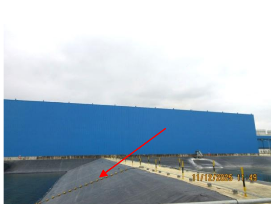
รูปที่ 3-22 การปูบ่อพักน้ำทิ้งด้วย HDPE
